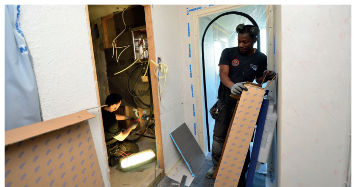
MASSERENOVASJON. Abdullah Erat (til venstre) og Lamin Camara i Trygg VVS er i full sving på et av flere hundre bad som skal rehabiliteres.
